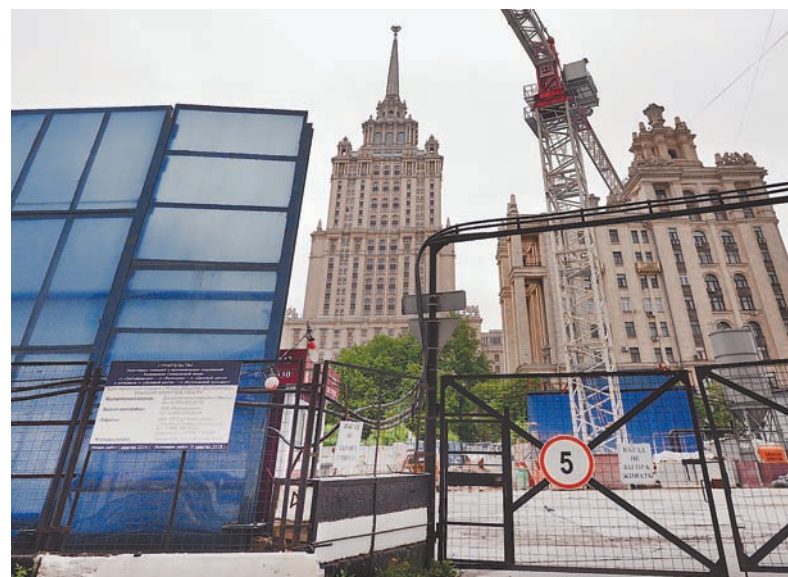
Уже несколько лет вид на высотку закрывает стройплощадка.
