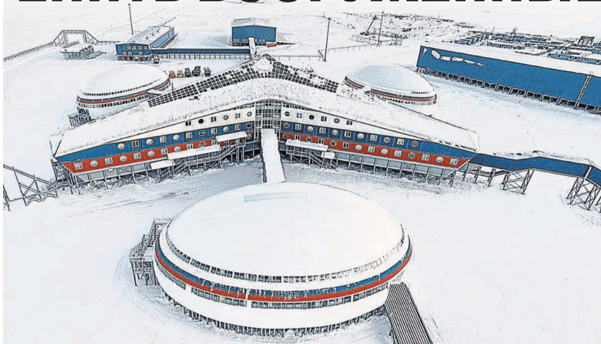
«Арктический трилистник» на острове Земля Александры — полностью автономная военная база и самое северное в мире капитальное сооружение.
