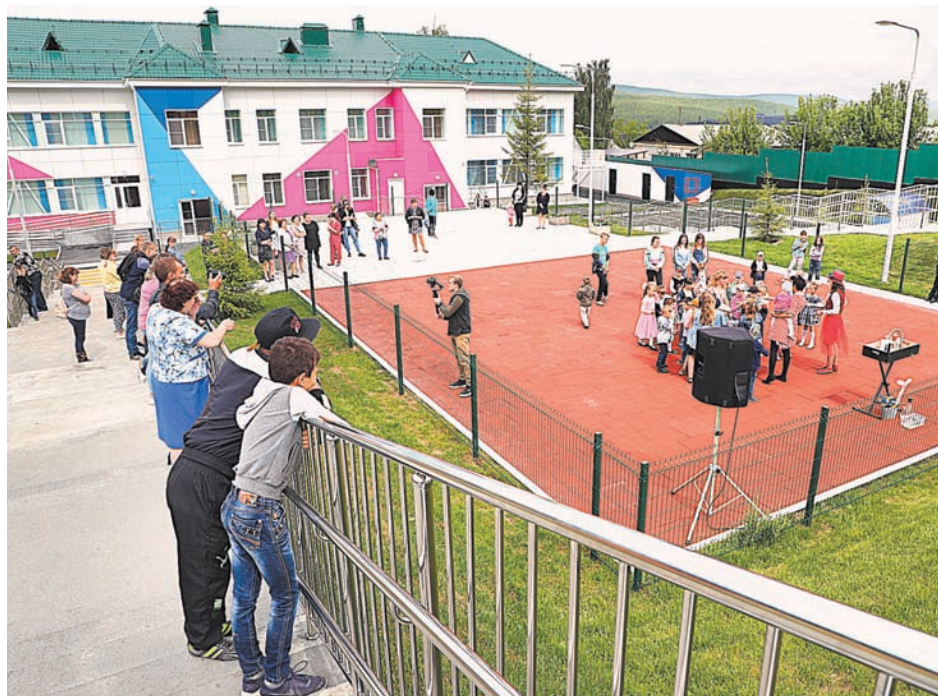
После капитального ремонта, проведённого на средства РМК, открылся детский сад в Карабаше (Челябинская обл.). Фото Андрея ЗАХАРОВА
