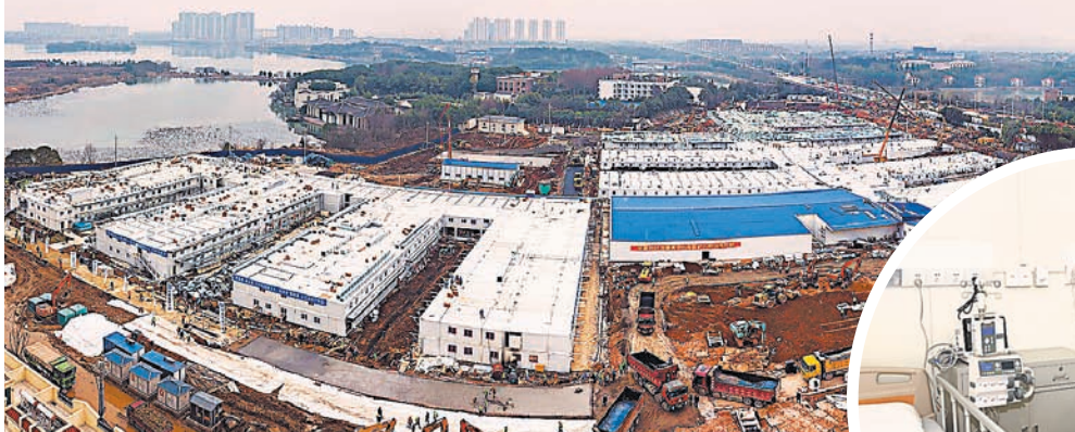
Первый госпиталь в Ухане для заражённых коронавирусом построен из готовых модульных конструкций. Второй возводится по такой же технологии. Фото Zuma/TACC, AP/TACC
