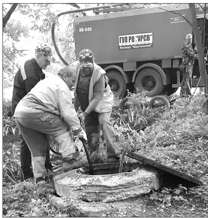
Режим ЧС позволит ускорить проведение ремонтных работ систем водоотведения.
