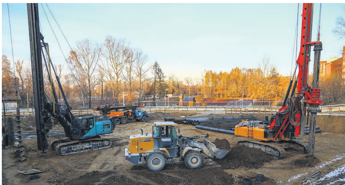
Строительство уже началось.
