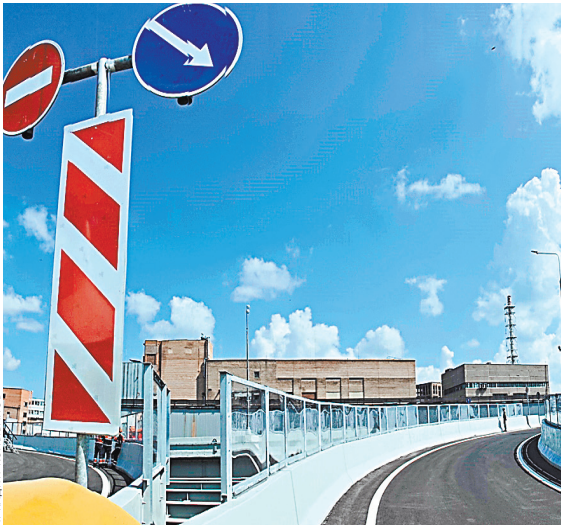
Построенная за год с небольшим развязка обеспечила дополнительными маршрутами 200 тысяч человек.
